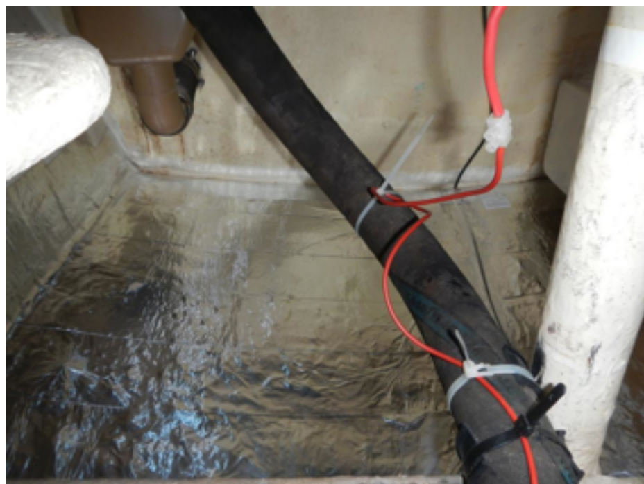
kapazitive Erdung mit Alufolie oder Kupferfarbe
